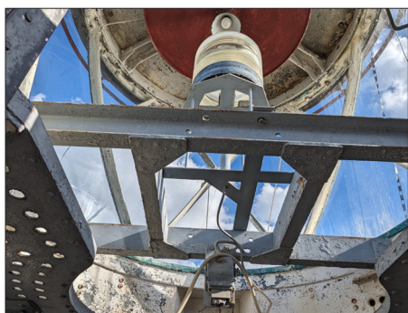
Bild E19: Über dem Brennmaterial- Raum befand sich das Leuchtfeuer.
